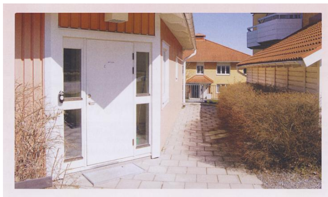
Entrén till den nedre tvättstugan.
