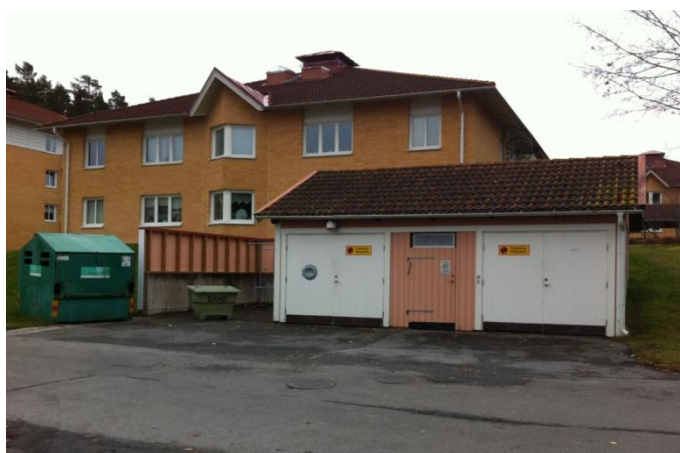
15. Nedre avfallsbyggnaden, med rum för el-avfall och bredvid till vänster finns en container för tidningar
